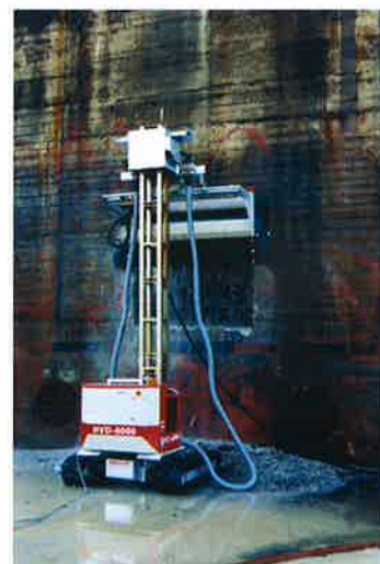
垂直壁の部分的なはつり作業
