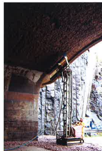
トンネル天井面のはつり作業
