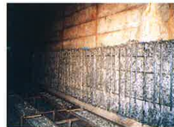
トンネル内壁面はつり
